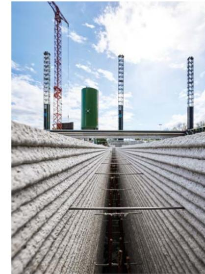
Die gedruckte Struktur der Fassade soll sichtbar erhalten bleiben, sodass hier ein Feinputz zum Verschließen der Poren und ein Farbanstrich erfolgen wird.
